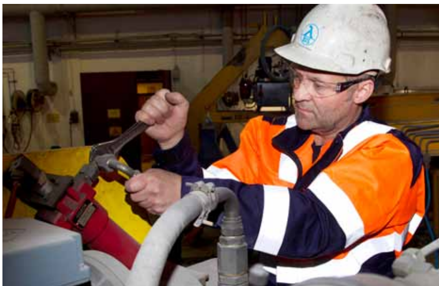
REPARASJON: Tore Sivertsen i arbeid med vedlikehold og reparasjon av en kryssrigg. Foto: Finn Arne Mortensen.
