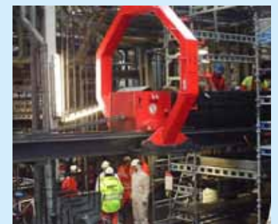
VARMEVEKSLERE: Mekanikere og riggere fra BIS PP er på Mongstad for å trekke ut og rengjøre 13 varmevekslere.
