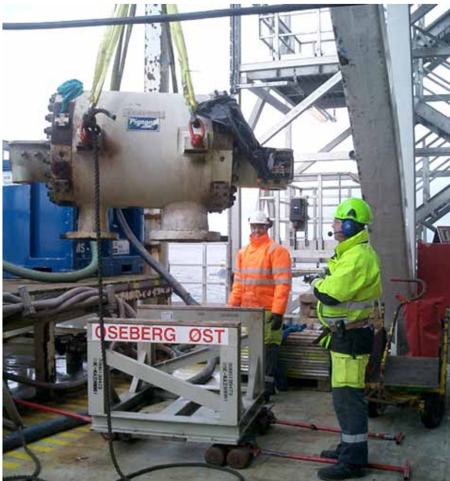
OFFSHORE: BIS PP deltok på revisjonsstanser på tre av Statoils plattformer i mai. Bildet er fra arbeidet på Oseberg Øst.
