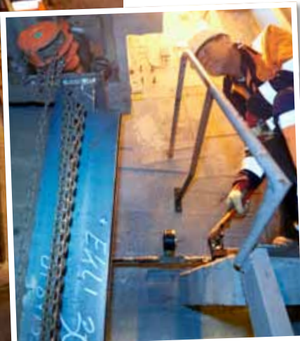
LØFT: Bruklaffen blir løftet med en hydraulisk jekk av Øistein Hermansen fra Rigg/kran.
