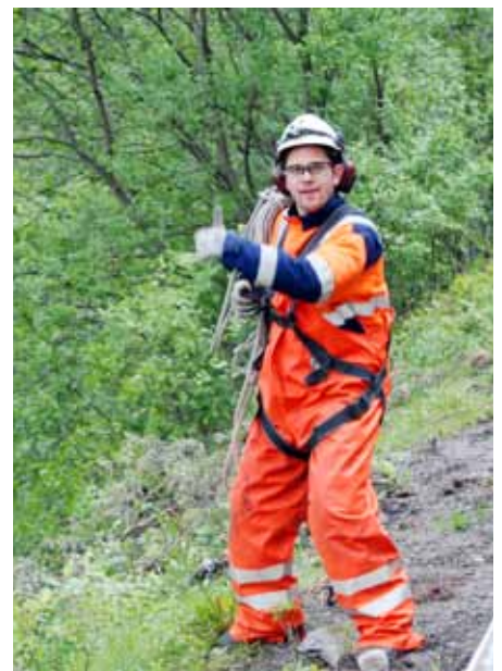
SIKRING: Arbeidet foregår i ulendt terreng, og det er lagt stor vekt på sikring av medarbeiderne.
