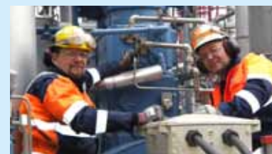
UTEN SKADER: Arbeidene gikk etter planen og helt uten skader. Her er Magnus Simonsson og Stefan Bäfer i full gang med arbeidene.
