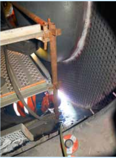
SVEISING: Det var 50 mm tykt gods som ble sveiset. 340 kg sveisetråd gikk med, og det ble sveiset kontinuerlig i ti døgn. Arbeidet inne i endecap'en ble gjort under svært vanskelige forhold.
