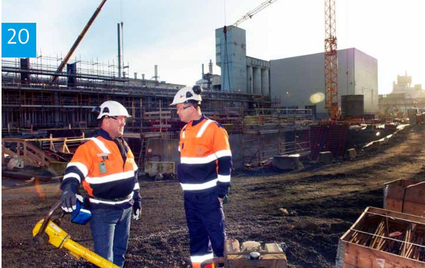
FRAMDRIFT: Engineeringsleder i RHI-prosjektet Jonny Olsen og leder av P&E, Jon Aasen, diskuterer noen detaljer i prosjektutviklingen. Begge er godt fornøyde med framdriften i prosjektet.
