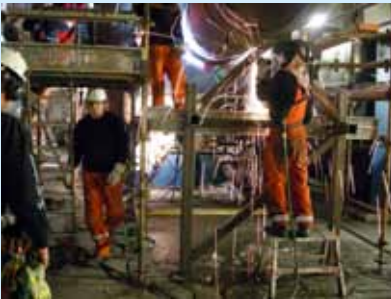
STØTTER: Flyttingen førte til at tilførselsørene til varmeveksleren måtte kuttes, og det måtte lages nye støttebukker når de skulle settes på plass igjen.
